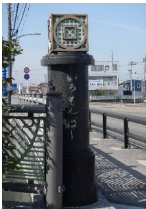
一文橋の橋柱
