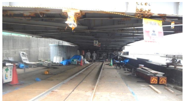
点検・修理している片持ち回旋橋を下から覗く
