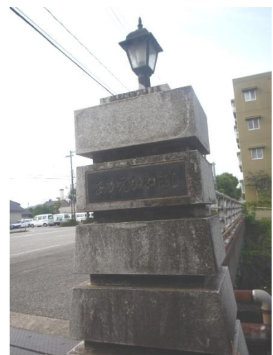
赤江川橋の橋柱
